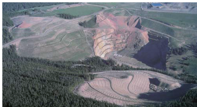
Figure 2 : mine d'or de Beal Mountain (Nevada) en voie de réhabilitation (Photo : A. Berger)
