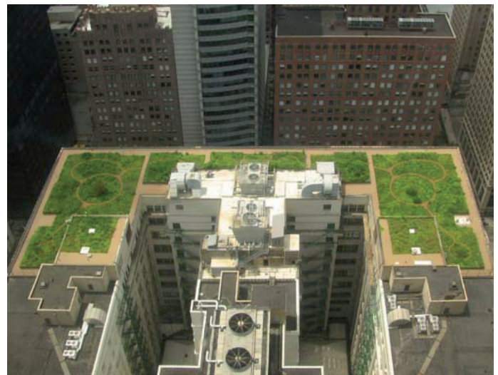
Figure 4 : toiture végétalisée du City Hall de Chicago, Etats-Unis (Wikipedia)
